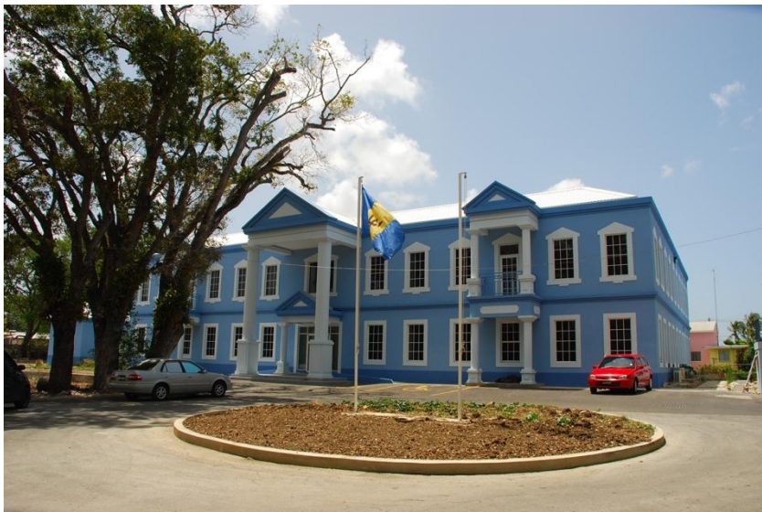
中建承包项目——工会新办公楼
