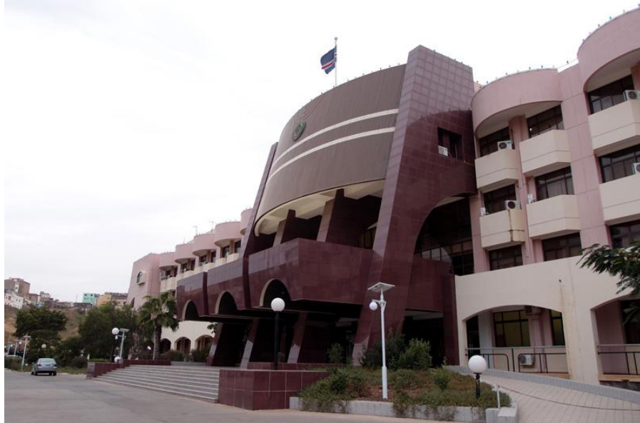
佛得角政府办公大楼
